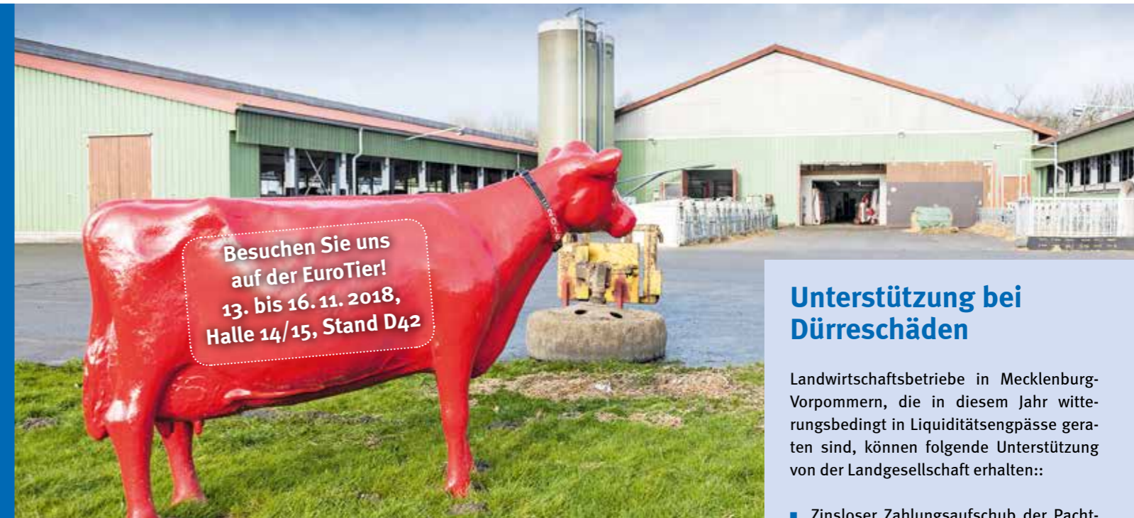
Milchviehanlage Prestin mit modernisierten Stallungen
