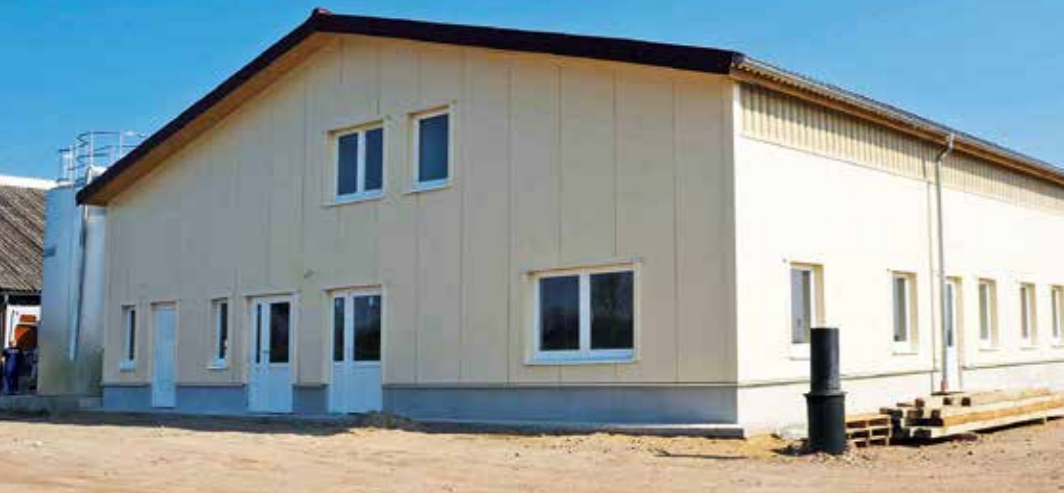
Der Neubau wurde nach modernsten technologischen Standards geplant und gebaut.
