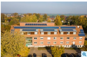
Solaranlage der LGMV geht an's Netz: Luftbild LGMV
