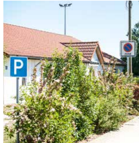
Vollständig saniert: das Sportlerheim in Papendorf
