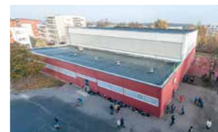
In der Sporthalle der Astrid-Lindgren-Schule wurden vor einigen Jahren Dach und Hallenfußboden erneuert.
