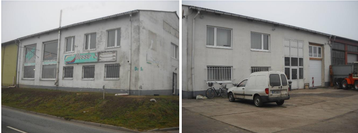
Abbildung 14: Straßen- und Hofansicht von Sozialgebäude und Werkstatt des Bauhofs
