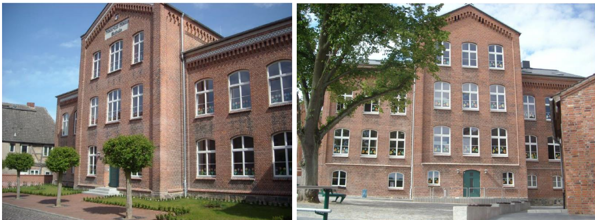
Abbildung 17: Frontansicht und Hofansicht Nordseite vom Hauptgebäude der Heinrich-Heine Grundschule
