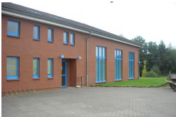
Abbildung 6: Saaltrakt mit Sanitärräumen
