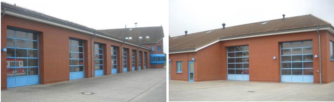
Abbildung 5: Fahrzeughalle und Waschgarage der Freiwilligen Feuerwehr
