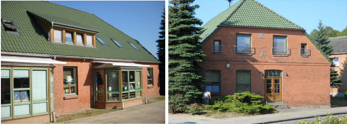
Abbildung 23: Südliche Ansicht mit Vorbau und Frontansicht auf Giebel (Ost) der Kita „Arche Noah“
