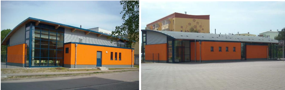
Abbildung 22: Südwestseite Hintereingang und Vorderseite (Nord) mit Blick vom Schulhof auf die Mensa
