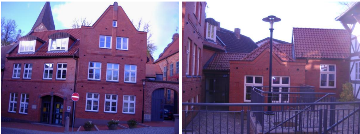
Abbildung 3: Süd- und Ostansicht des Neuen Rathauses
