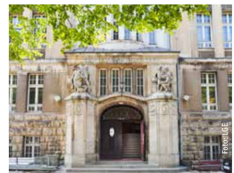
Noch unsanierte Fassade der Erich-Weinert-Schule
