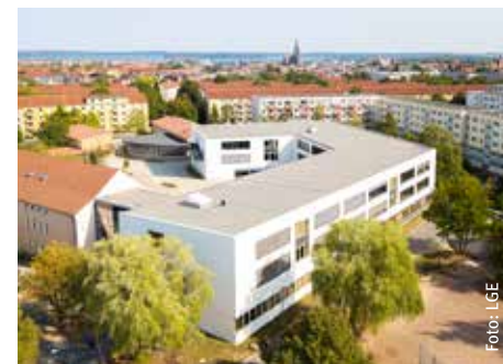
Neubau des Schulkomplexes Goethe-Gymnasium
