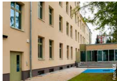
Saniertes Hortgebäude „Schwerin-Mitte“
