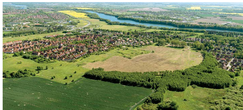
Das Baugebiet in Schwerin-Friedrichsthal
