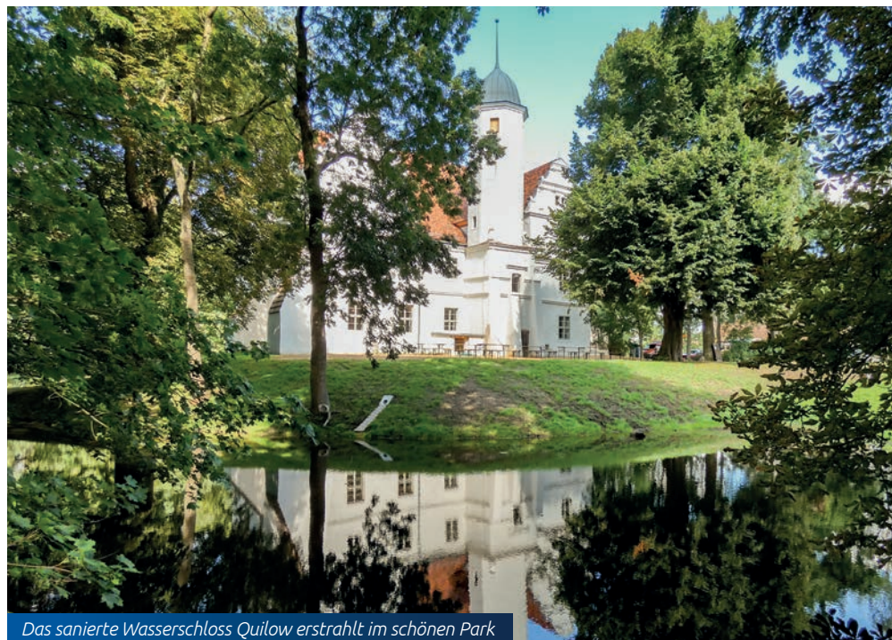
Das sanierte Wasserschloss Quilow erstrahlt im schönen Park
