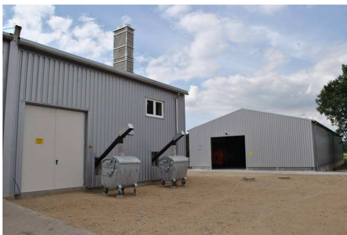
Heizhaus für Strohheizungsanlage und Aschecontainer (Foto LGMV)
