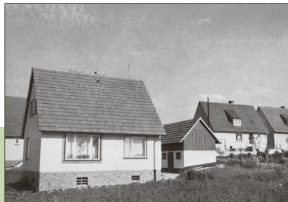
Landarbeiter-Siedlerstelle im Kreis Eschwege
