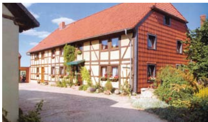
Dorferneuerung: Modernisierung eines landwirtschaftlichen Wohngebäudes, Abbenrode / Niedersachsen
