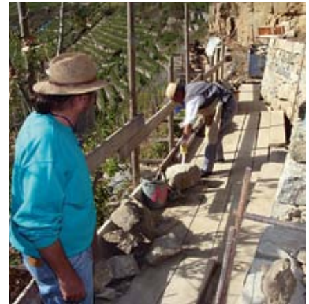
Arbeiten im Weinberg hoch über dem Enztal bei Roßwag
