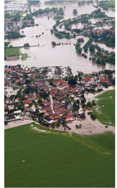
Hochwasser Juni 2013, Ortslage Caaschwitz
