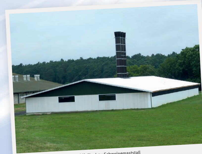
Schweinemast Groß Babelin GmbH: Neubau Schweinemaststall
